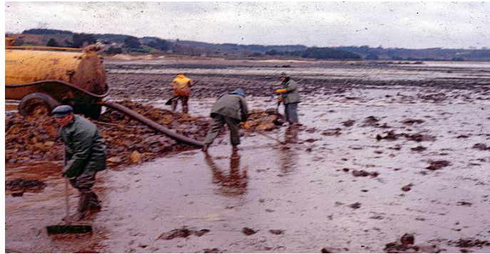
شكل 9 عملية كشط البقعة النفطية من على سطح الماء
