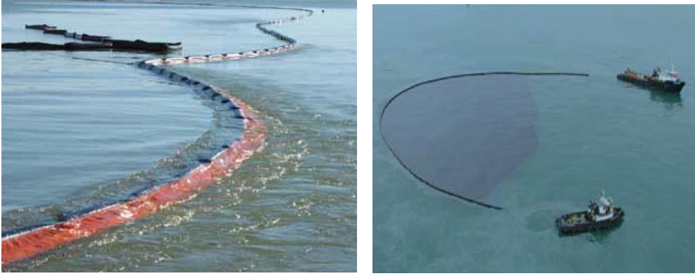
شكل 8 استخدام الحواجز الطافية للسيطرة على البقع النفطية
