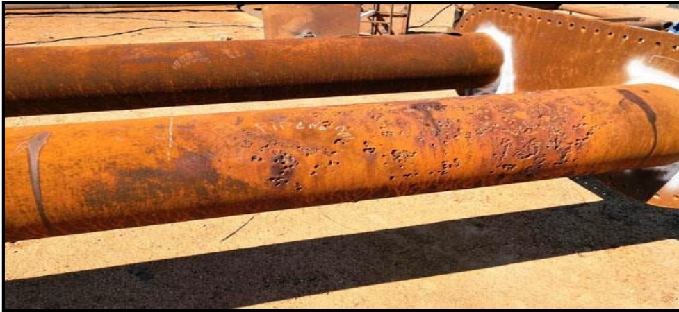
الشكل (3) التآكل في الأنابيب
