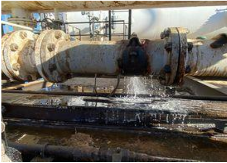
الشكل (19) يوضح leak الذي حدث في out let of water
