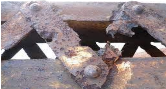
الشكل (1) يوضح اجزاء حدث بها التآكل
